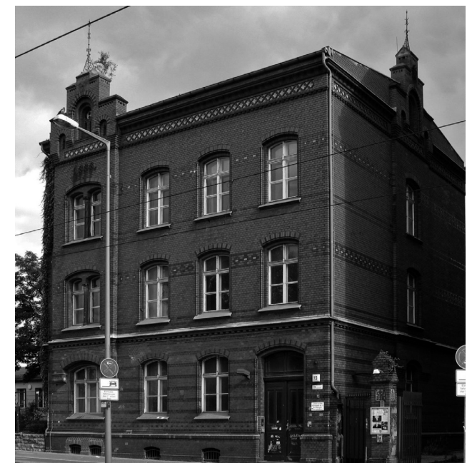
Fachada da Casa do Artista Die Wache – Die Wache significa “a guarda” em alemão. O edifício foi um posto policial construído no final do século XIX.
