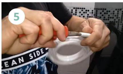
5 Tire a ponta da água e insira o alicate dentro dela até ele ficar preso para alargar a ponta. Retire o alicate e rapidamente, antes que o material se contraia novamente, a encaixe no lugar da mangueira no chuveiro
