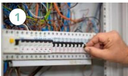
1 Coloque água para ferver. Depois acesse o quadro de distribuição e desligue o disjuntor que corresponda ao circuito elétrico do chuveiro. Se em dúvida, desligue todos.
